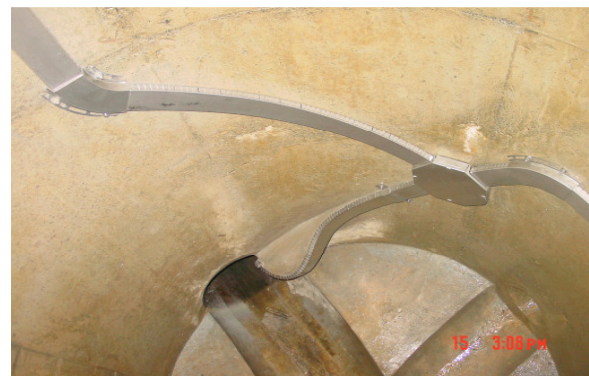
Schachttanker mit Teleskopbogen und Kreuzung
