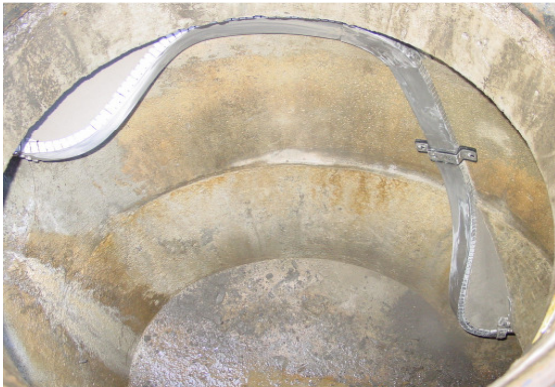
Schachtverbau, höhenversetzt
