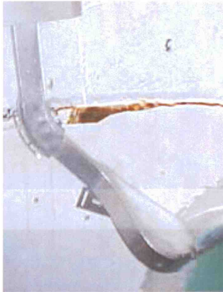
Abbildung 0.7: Kanalanker mit Biegeradiuskontrolle
